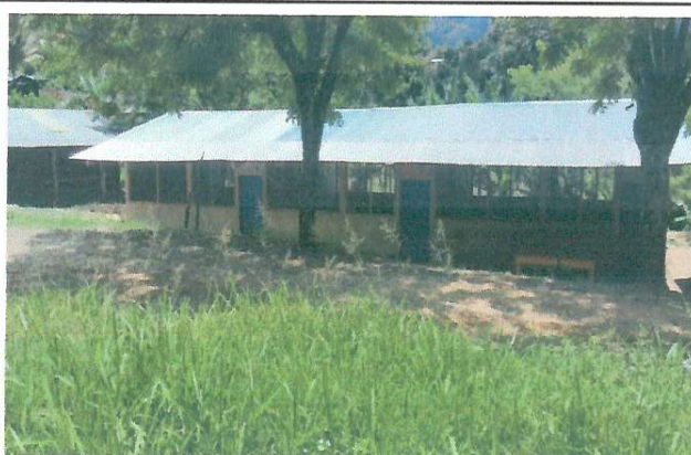
Foto 4: Correspondiente Cambio de cubierta de techo con lamina troquelada calibre 26 y sustitucion estructura portante.
